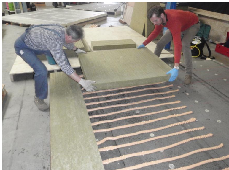
Foto 3 Die Wärmedämmung wird angebracht.
