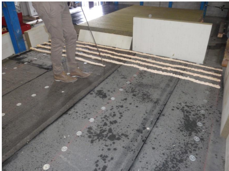
Foto 2 Die Dachbahn (Dampfsperre) wurde mechanisch befestigt und das Klebemittel wird streifenweise gespritzt angebracht.
