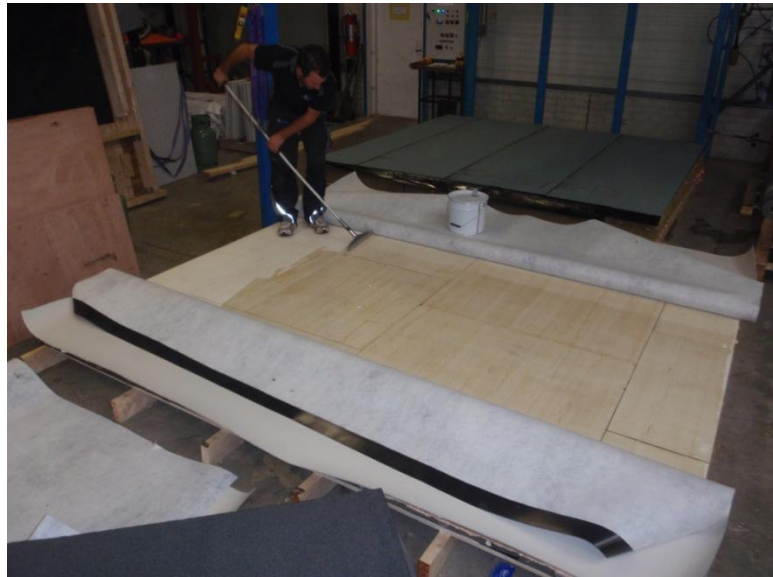
Foto 4 Das Klebermittel wird mit Schmieren angebracht.
